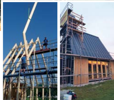
Aufrichten des Dachstuhls und die fertige Außenfassade
